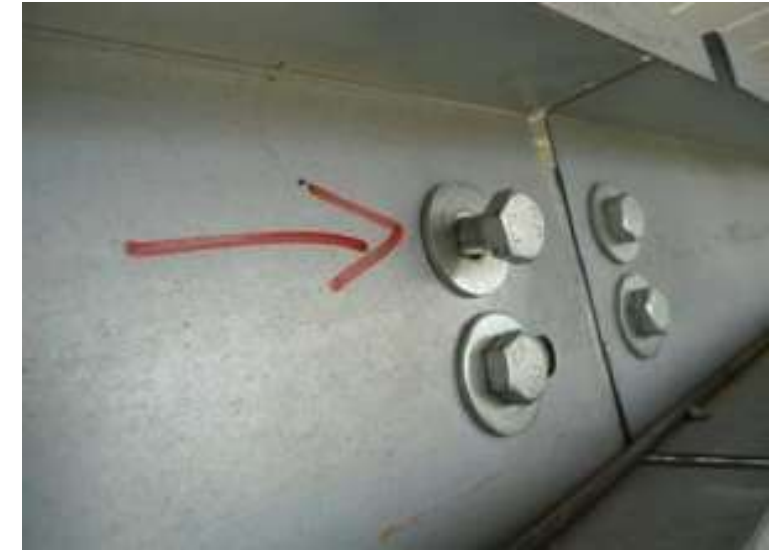
Aflojamiento de los tornillos de sujeción de los perfiles transversales
