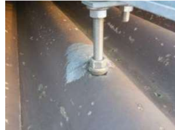
Falta de sellado de los orificios de penetración
